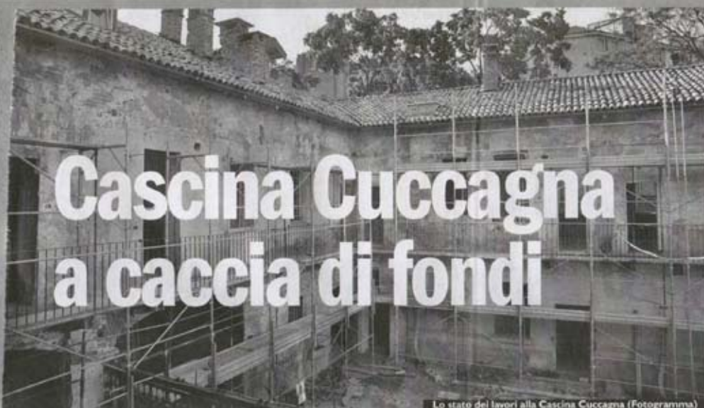
Lo stato dei lavori alla Cascina Cuccagna (Fotogramma)
